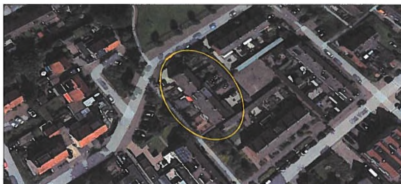
Afb 2: Het complex aan Het Veer
