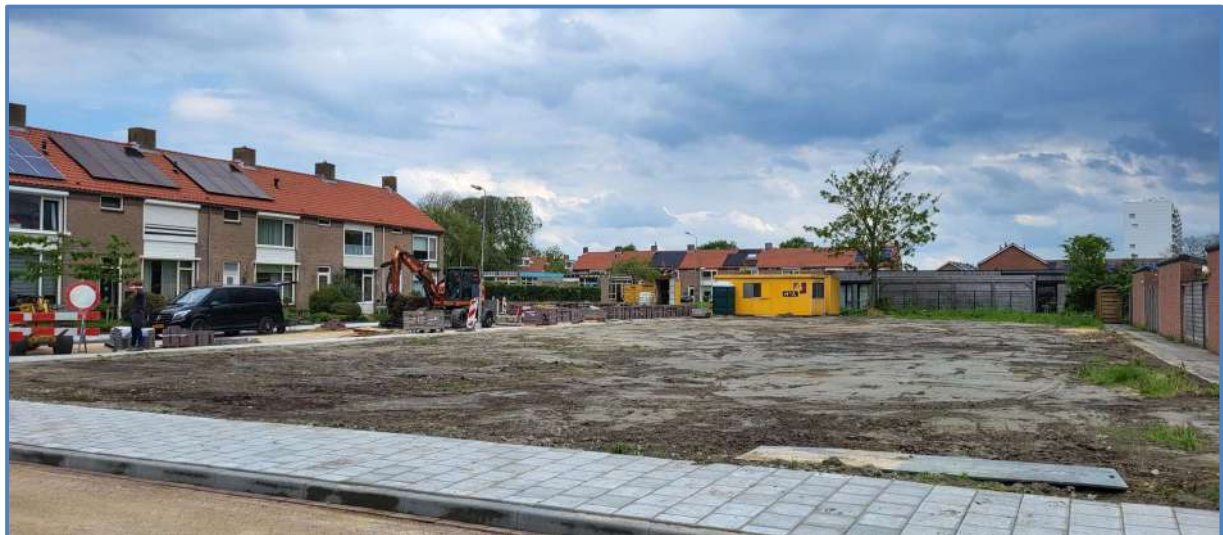
Zicht op het bouwkvael aan Van Ginkelstraat in Oost-Souburg, 12 mei 2023.
