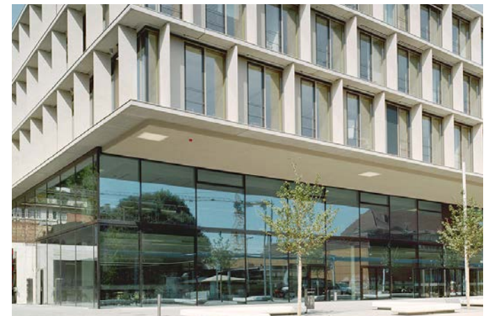
Terugliggende gevel: IHK Region, Stuttgart.
