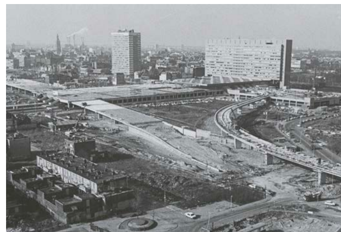
Aanleg Utrechtsebaan en Prins Bernhardviaduct (opening 1975)
