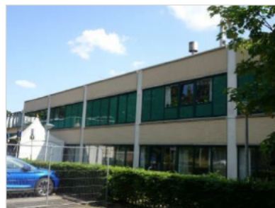
Figuur 2.5 De noordgevel waar de nieuwbouw op aan komt te sluiten, gezien vanaf het noorden.
