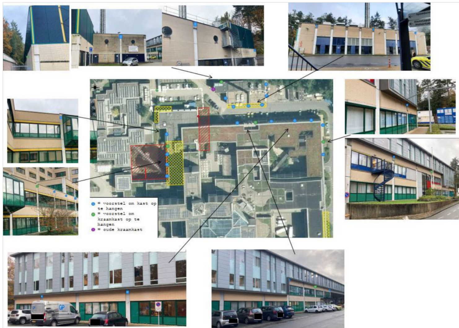
Figuur 7.4 Voorstellocaties voor de plaatsing van de tijdelijke vleermuiskasten met impressiefoto's.
