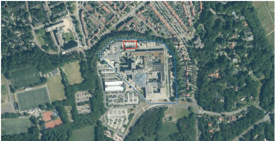
Figuur 1 Luchtfoto van het plangebied (rood omrand) en de onderzoekslocatie (blauw omrand) en directe omgeving.
