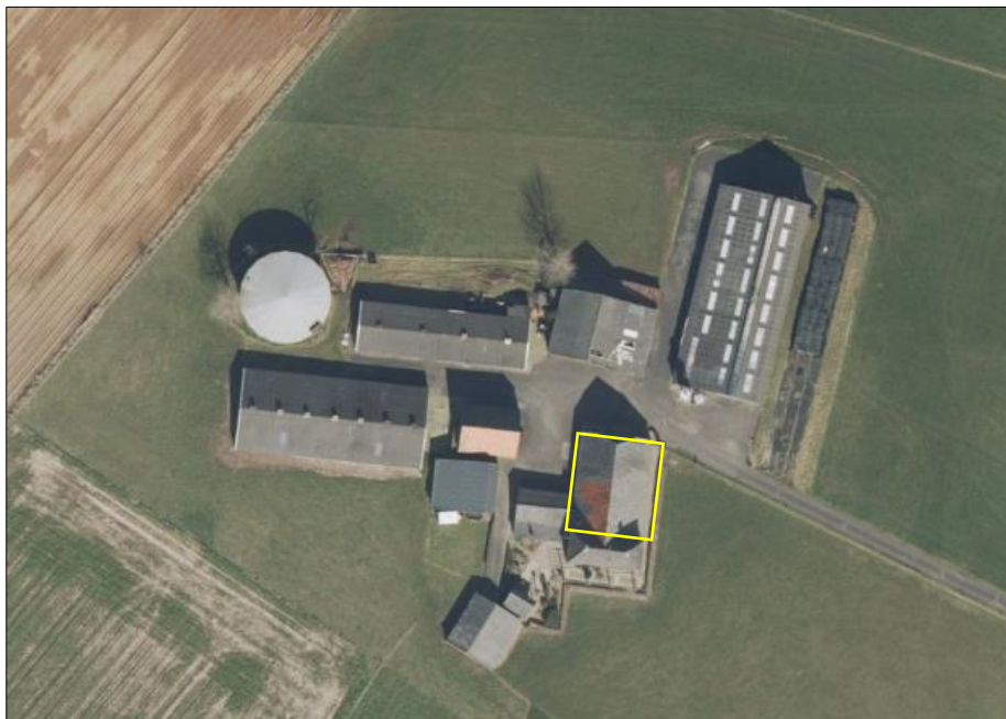
Aanduiding van de te slopen 'deel' van de boerderij; aangeduid met gele lijn.
