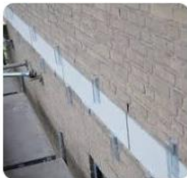
Voorbeeld van schuimworst. Geschikt materiaal voor afdichten invliegopeningen.
