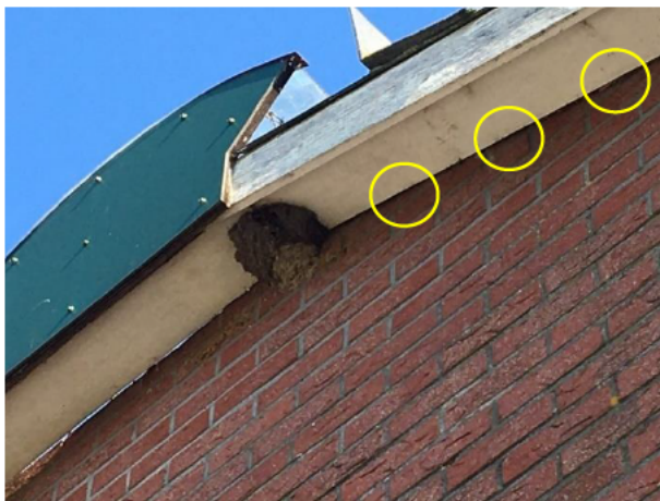
Er zijn kieren (gele cirkels) waargenomen tussen de betimmering van het dak overstek en de buitengevels van de ligboxenstal.
