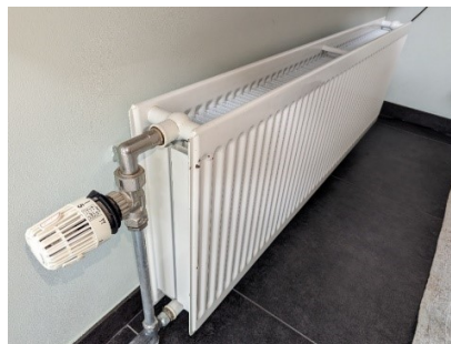
Figuur 16: een 'gewone' radiator die past bij de temperatuur van een cv-ketel op aardgas
