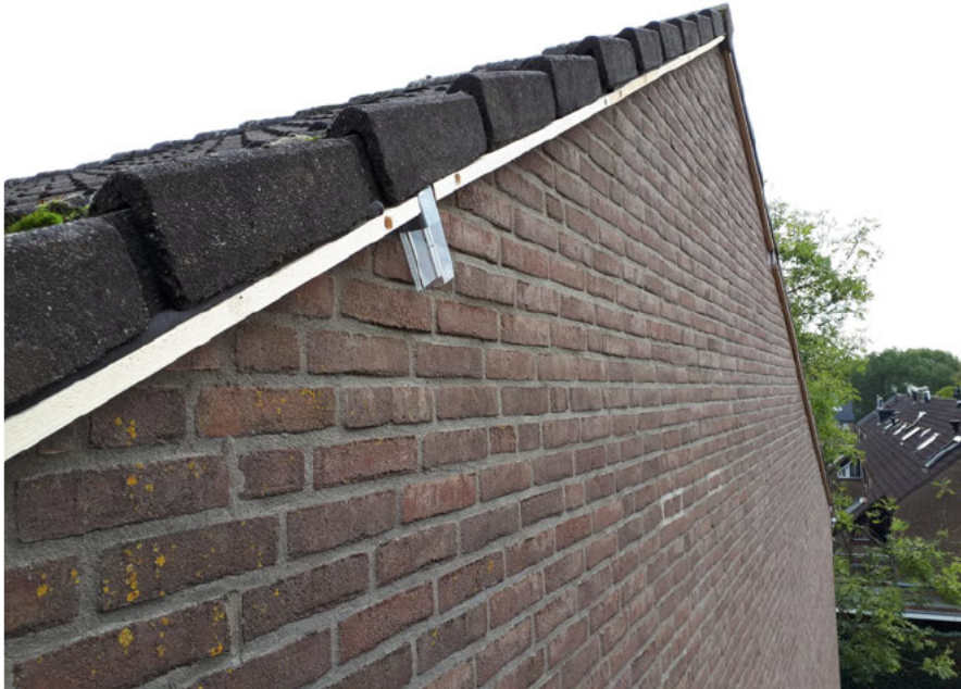
Detail exclusion flaps met panlatten en rugvulling.
