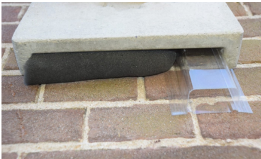
Muurschaal met exclusion flap en verder afgesloten met kitrugvulling
