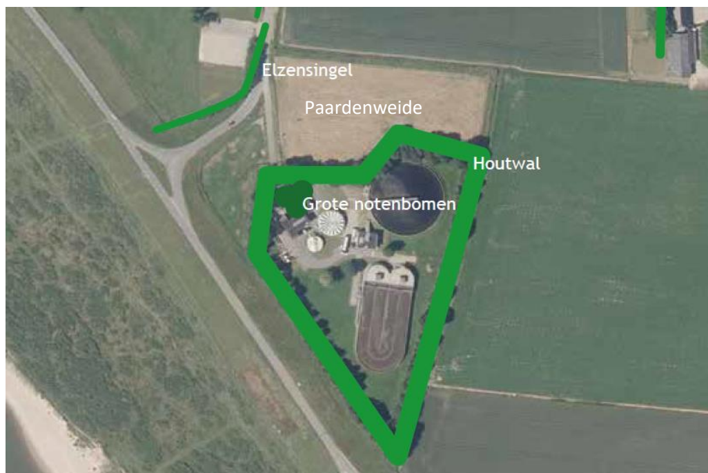
Afbeelding 1 Huidige situatie van het RWZI terrein in Gendt. De aanwezige houtwal aan de noordzijde zal worden gekapt en in de paardenweide zullen de zonnepanelen worden geplaatst.
