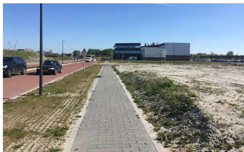
Nieuwbouw locatie Eurofins Biopharma product testing
