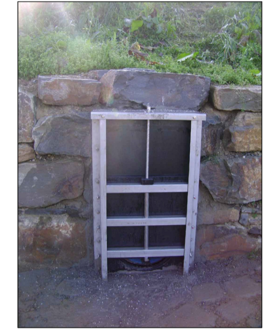
WENSBEELD STAPELMAUR MET SPINDELSCHUIF
