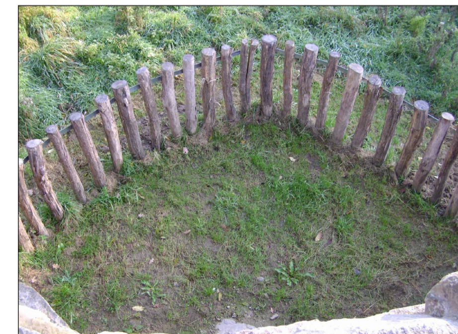
WENSBEELD VULVANG VAN ROBINIA PALEN INCLUSIEF STALEN BAND
