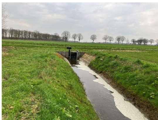
Afbeelding B.3.3.2: Impressie stuwlocatie, vanuit zuidoostelijke richting.
