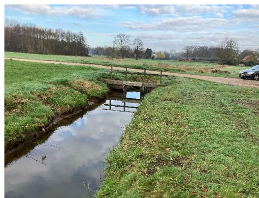
Afbeelding B.2.1.3: Impressie stuwlocatie vanuit zuidelijke richting, met ingestorte beverholten zichtbaar op de slootkant (links in beeld).
