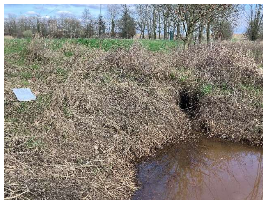
Afbeelding B.2.5.3: Impressie zuidzijde dijklichaam broekweg met beverhol in talud.
