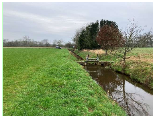
Afbeelding B.2.7.3: Impressie stuwlocatie vanuit zuidoostelijke richting.
