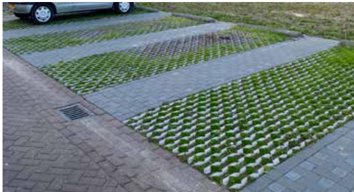
parkeervakken worden uitgevoerd in grasbetonstenen
