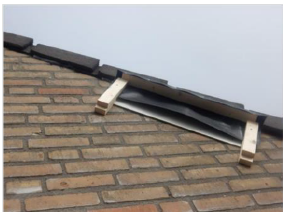
Figuur 8.11 Voorbeeld van geplaatste exclusion flap toegepast op opening tussen de gevel en dakrand.
