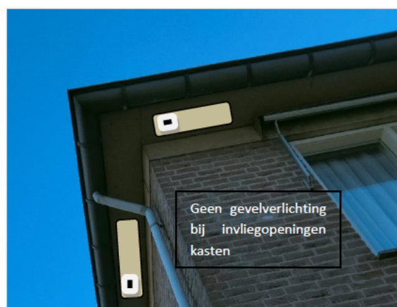
Figuur 8.18 Optie 2: instructies plaatsen inbouwkasten VMP3 in dakoverstek.
