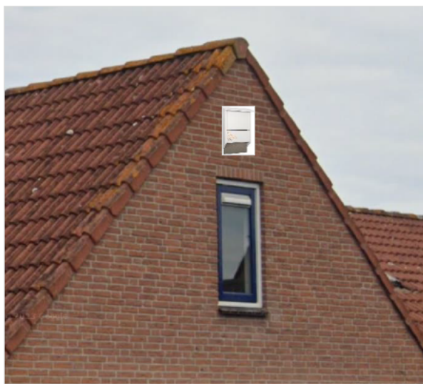
Figuur 8.9 Plaatsing tijdelijke vleermuiskast VK MP 08 in de nok van Kasteelhof 1 en 7.
