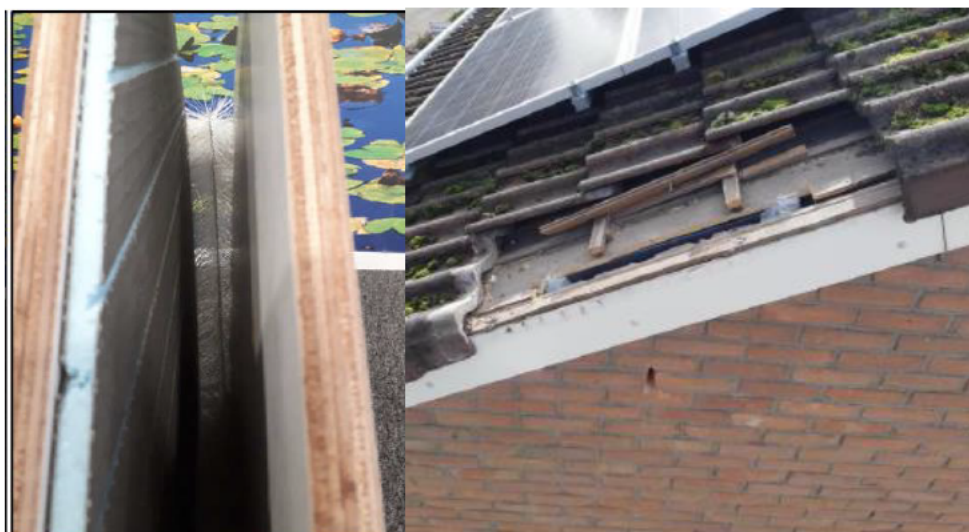
Figuur B2 Links: Impressie wedi-plaatvoorziening in de spouw. Rechts: toegankelijke ruimte in de spouw via een open stootvoeg met verbinding met het dak. Bron foto's: Ecogroen.
