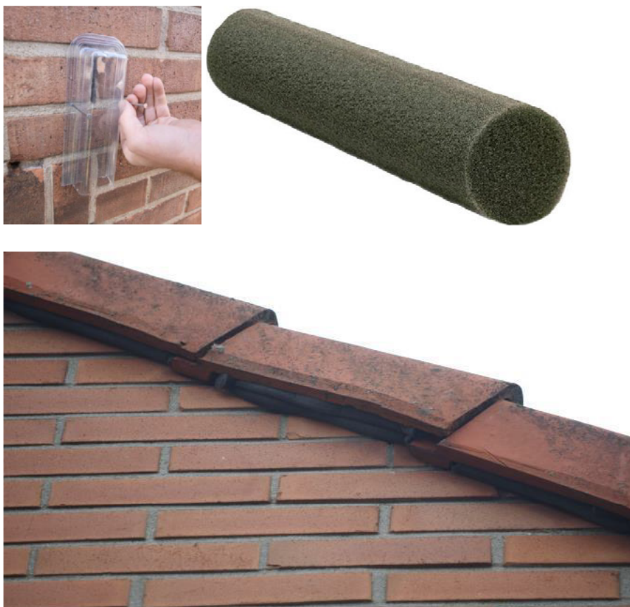
Figuur 6.1 Voorbeeld van een vleermuiskoker op een open stootvoeg (linksboven) en rugvulling (rechtsboven) en rugvulling nabij kantpannen (onder) om gaten en kieren mee op te vullen. Bron: Unitura.
