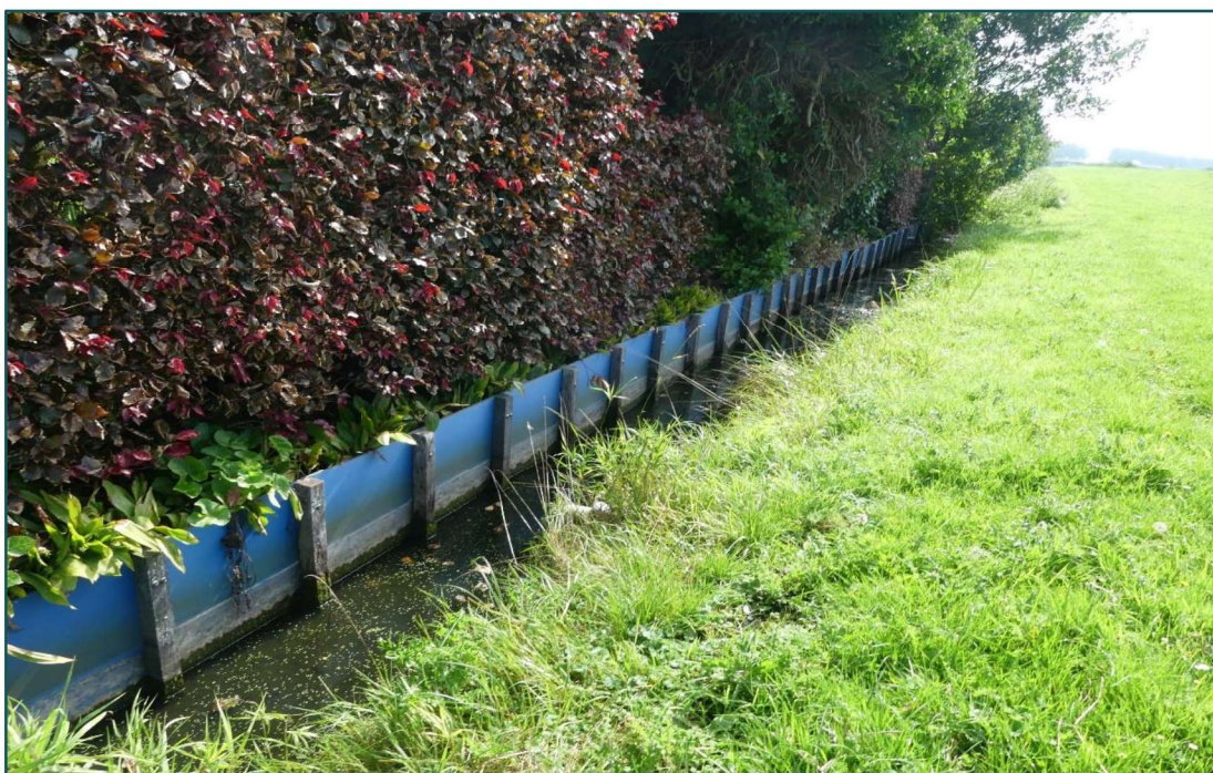
Figuur 4 De sloot aan de westzijde van de planlocatie, welke waterhoudend is en beschikt over beschoeiing.
