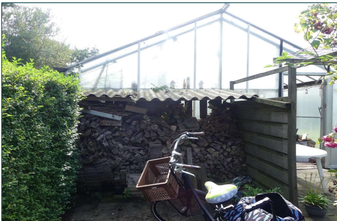
Figuur 2 De overkapping met houtopslag aan de voorzijde van de kas.
