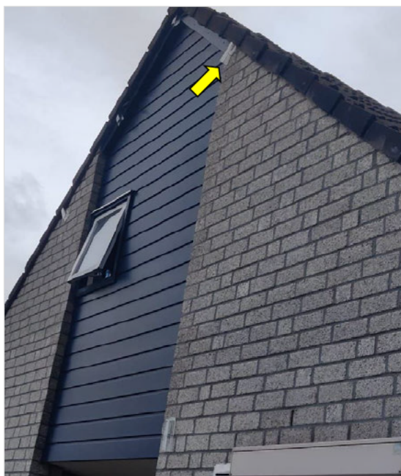
Figuur 8.4 Voorbeeld van geplaatste exclusion flaps (bij gele pijl) bij dak.
