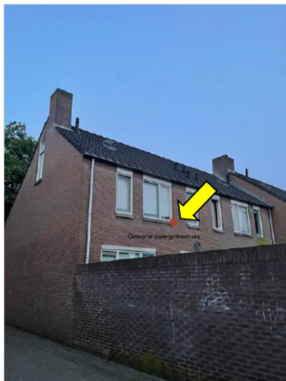
Figuur 4.2 Locatie van ingevlogen gewone dwergvleermuis onder raamkozijn (gele pijl) aan De Garf 11.
