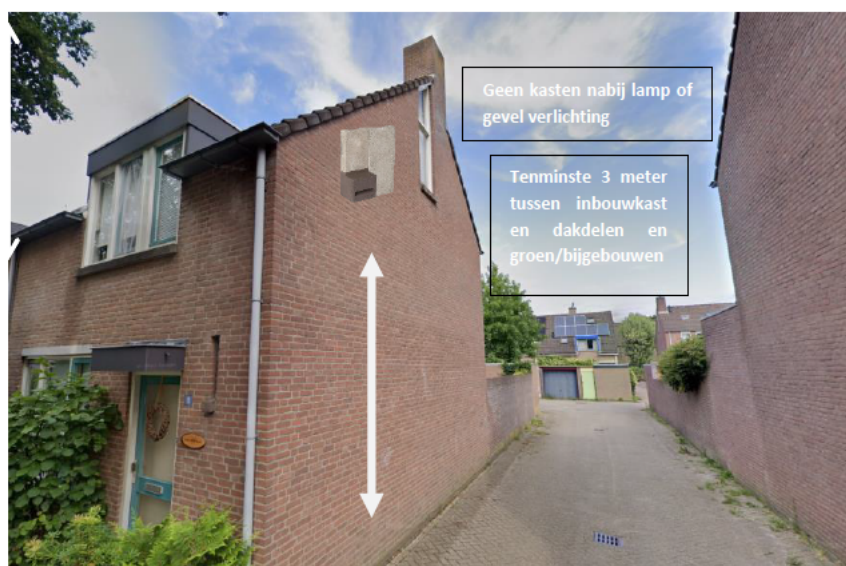
Figuur 8.8 Instructies plaatsen vleermuiskast in kopgevel.
