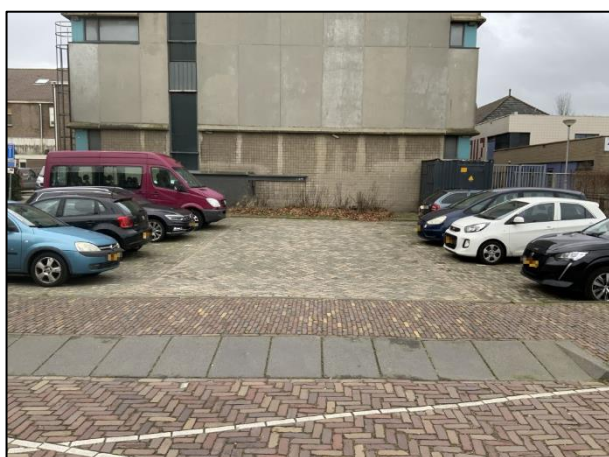
Foto 11: Noordzijde van de onderzoekslocatie, gezien in zuidelijke richting
