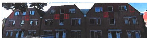
Figuur 10. Set van inbouwvoorzieningen en WEDI-voorzieningen ingetekend op de gevel. Fotobron: Google Street View
