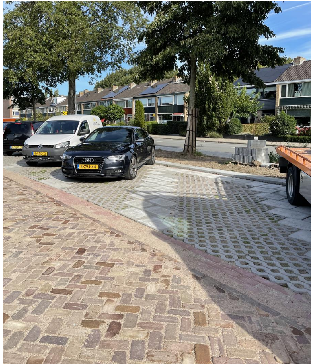
Waterpasserende verharding en groene parkeervakken Van Lennepstraat
