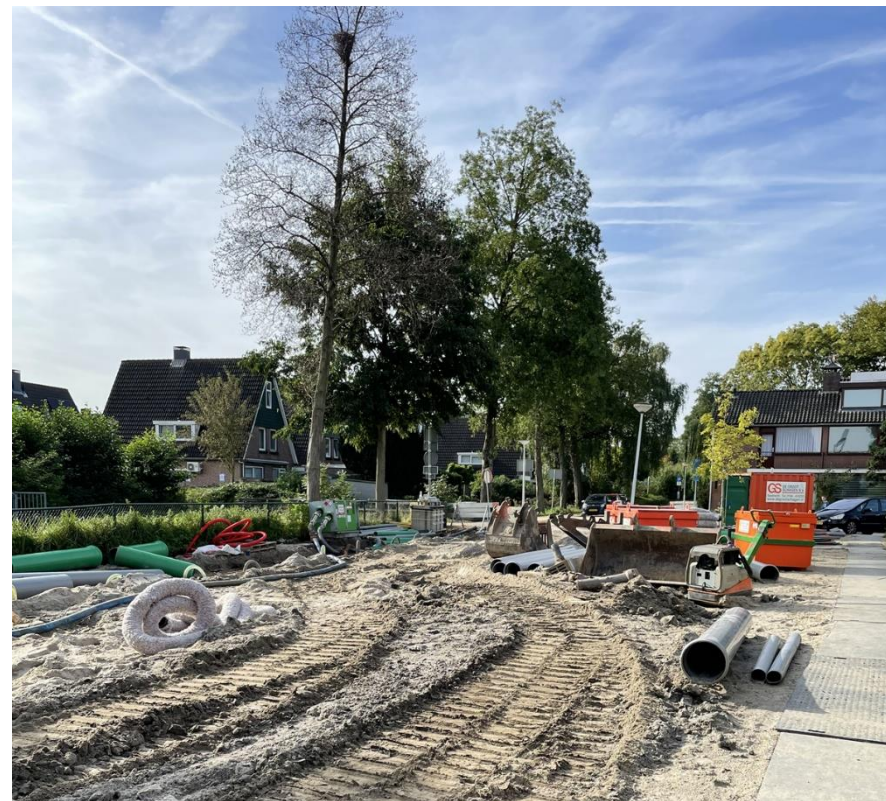
Vervanging riolering Noordersingel
