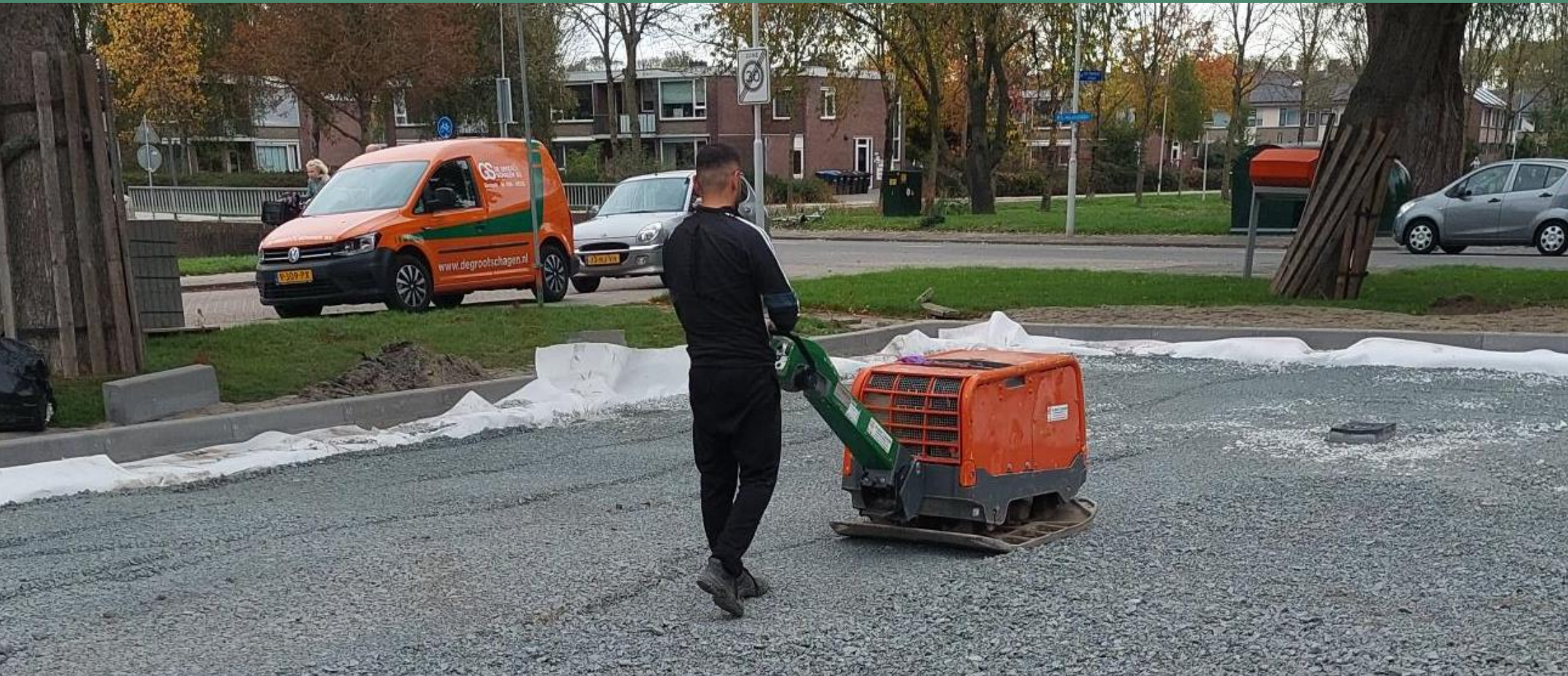
Aanleg waterbergende wegfundering Da Costastraat
