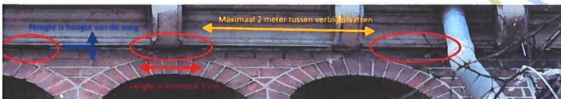
Figuur 1: Afmetingen van de openingen van de permanente voorzieningen.
