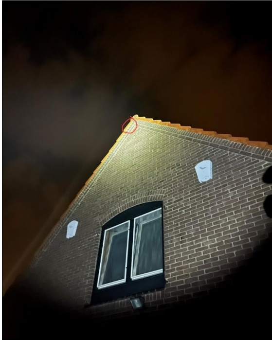
Foto 3. Locatie van het aangetroffen paarverblijf onder het dak van de bedrijfswoning (nummer 1)
