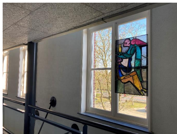
Afwerking ramkozijn binnenzijde
