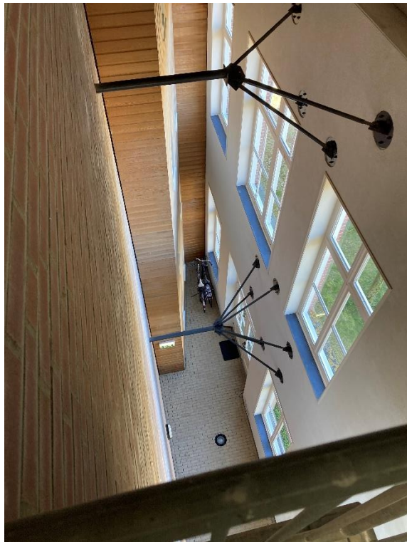
Verbinding rechter zijgevel met nieuwbouw
