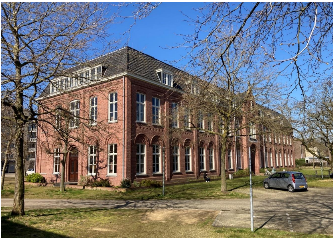
Linker zijgevel en voorgevel
