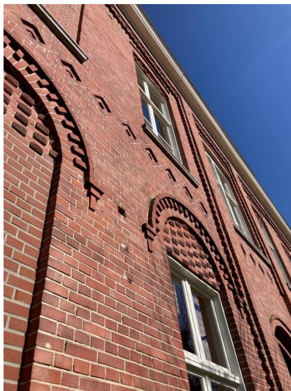
Detail baksteengebruik linker zijgevel
