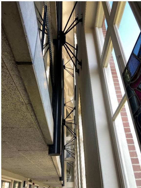
Verbinding voorgevel met nieuwbouw
