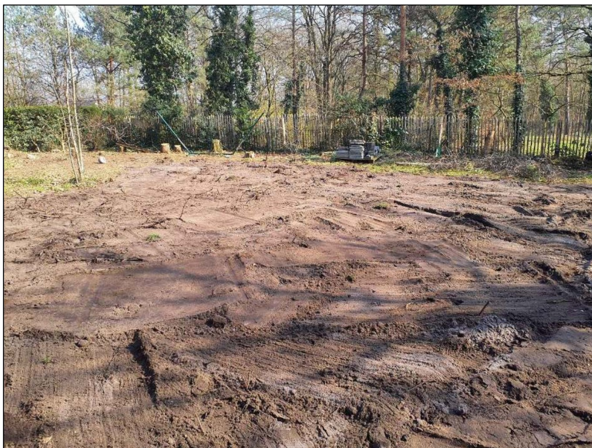
Afb.2 – Het opsporingsgebied [REDACTED] na opsporingswerkzaamheden.
