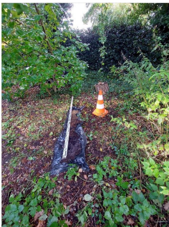
Figuur 0.1 Locatie grondboring 1.
