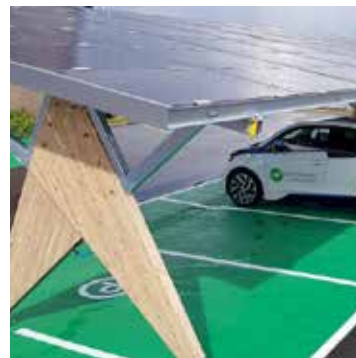
overkapping met zonnepanelen
