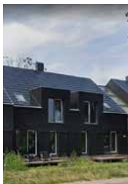
zonnepanelen geïntegreerd in dak
