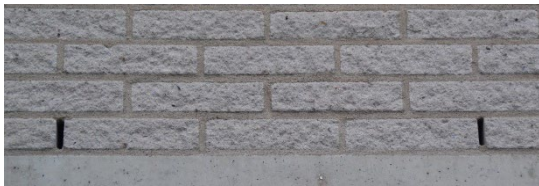
Figuur 9.6: Open stootvoegen of ruimte tussen kantpannen en windveer bieden toegang voor vleermuizen tot rustplaatsen
