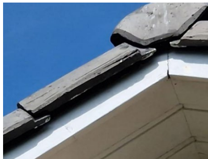
Figuur 9.6: Open stootvoegen of ruimte tussen kantpannen en windveer bieden toegang voor vleermuizen tot rustplaatsen
