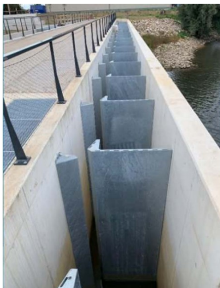
Figuur 2-3 Impressie vertical slot vispassage (bron: Nepocon.nl, stuwcomplex van Doesburg)
