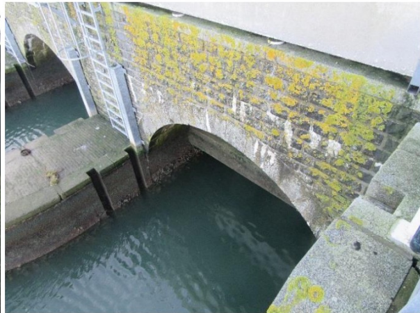
Detail koker aan noordzijde, met schildmuur
