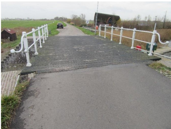
De brug in het wegdek van de Schardam
