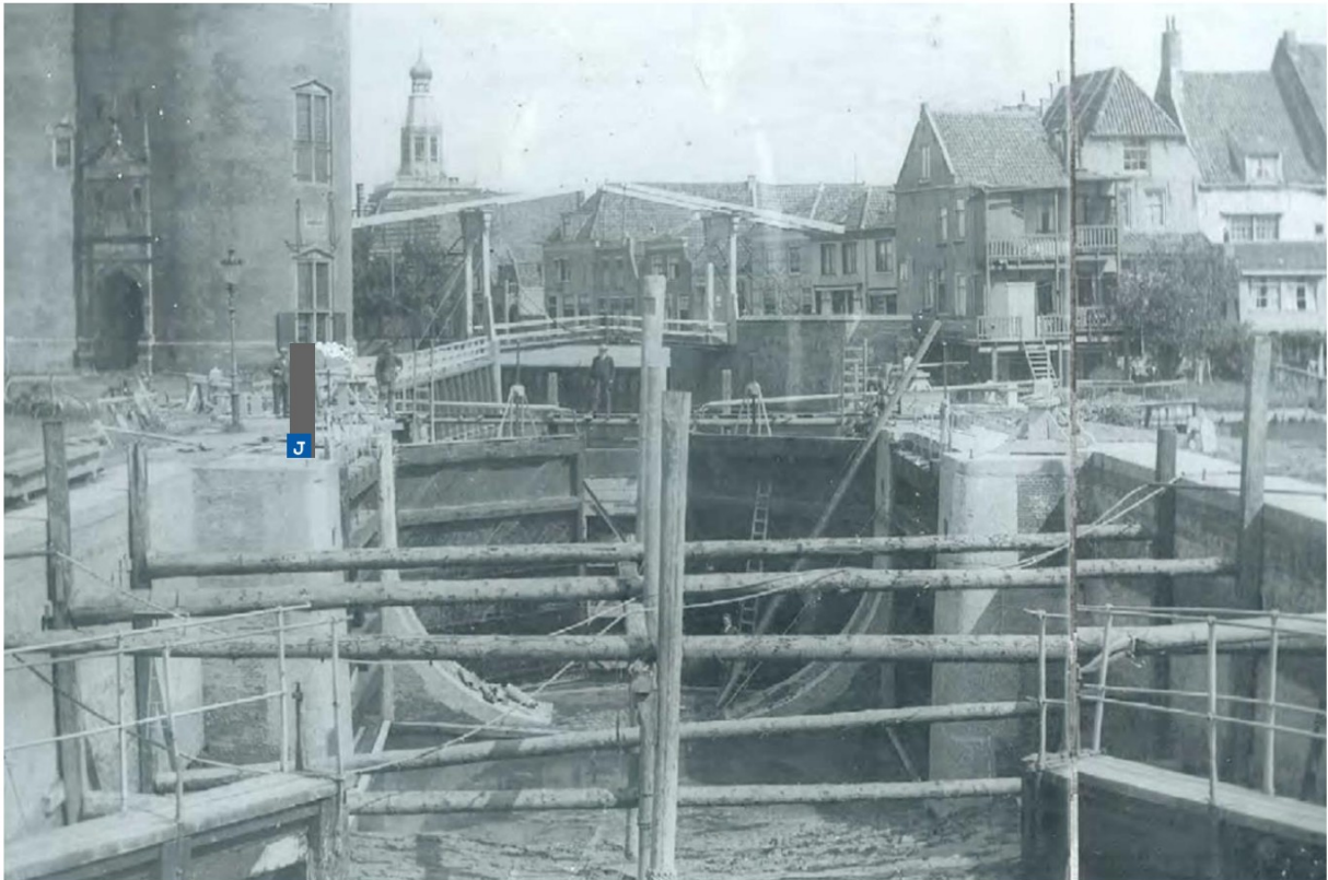
Restauratie in 1928, waarop de getoogde steunberen zichtbaar zijn (Bron: Ralling)
