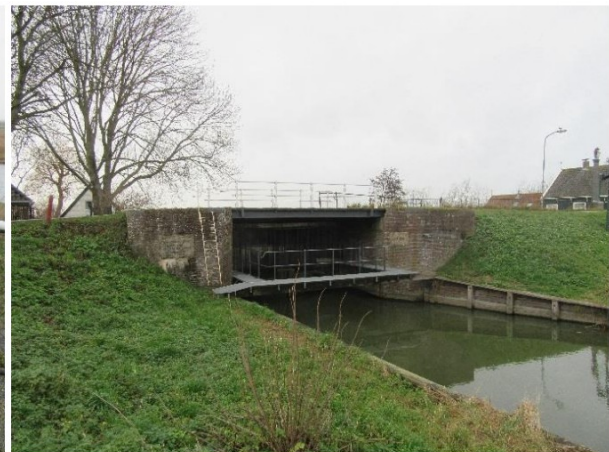
Buitenhoofd Zuidersluis, gezien van buitenzijde
