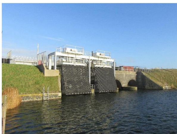
Inlaatzijde aan het Balgzandkanaal
