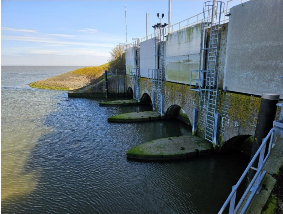
Figuur 2.3 De noordzijde van de spuisluis
