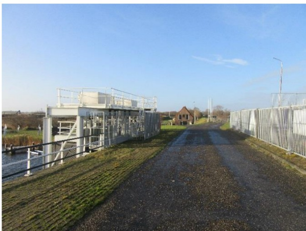
Weg over de sluis, gezien in westelijke richting
