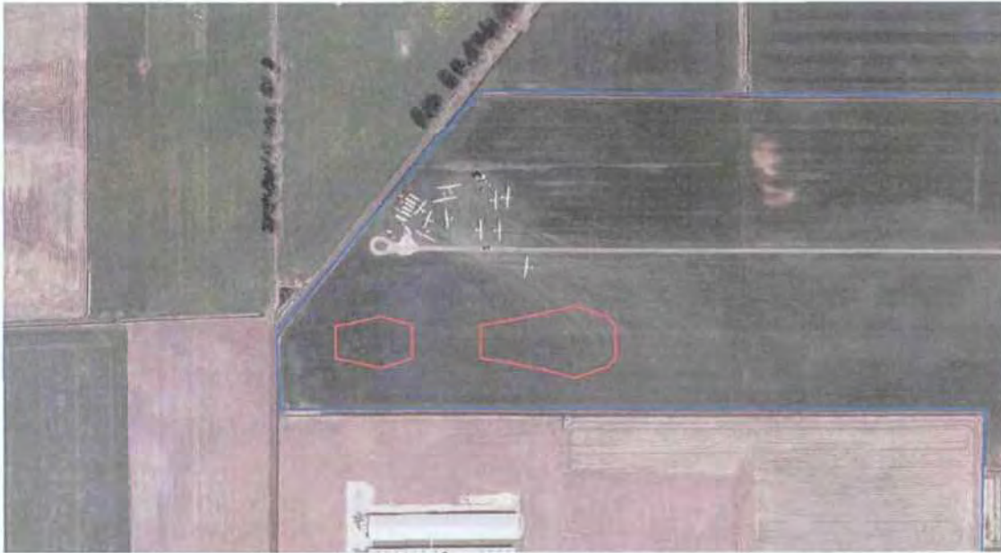
Fig.4 Plaatsgebonden risicocontouren 10^{-6} per jaar rood van het westelijke deel van het vliegveld Lemelerveld.
