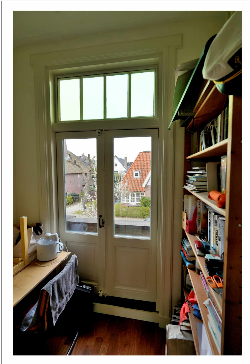
Kozijn E deurkozijn - 1 e etage
