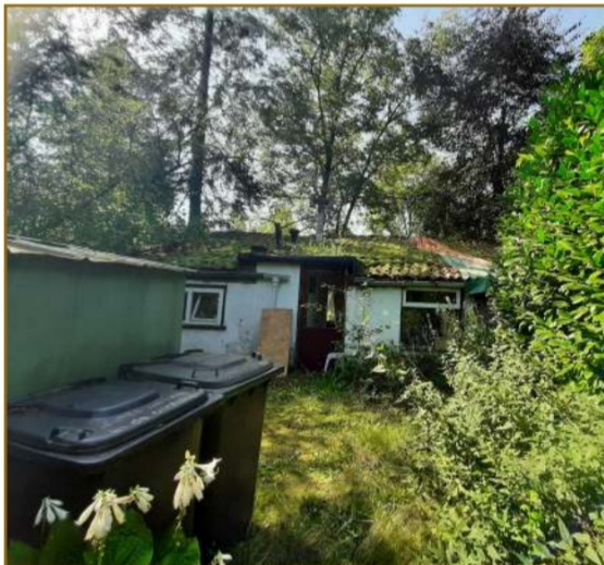
Afbeelding 9: Een vervallen huis in het noordelijk deel van het plangebied.
