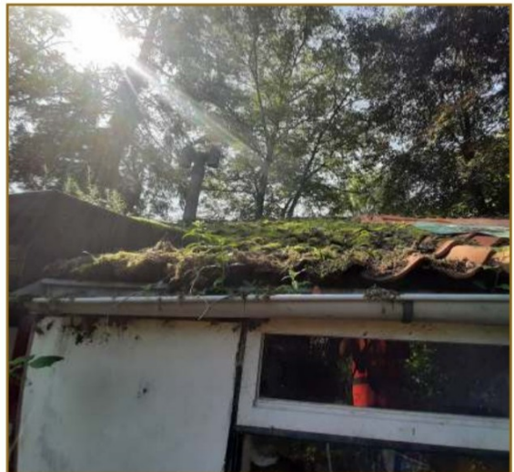
Afbeelding 10: De ruimte onder de dakpannen was overal te inspecteren. Er zijn geen nesten aangetroffen.
