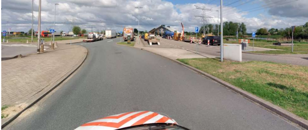
Situatie t.h.v. uitrit en doorsteek constructie.
