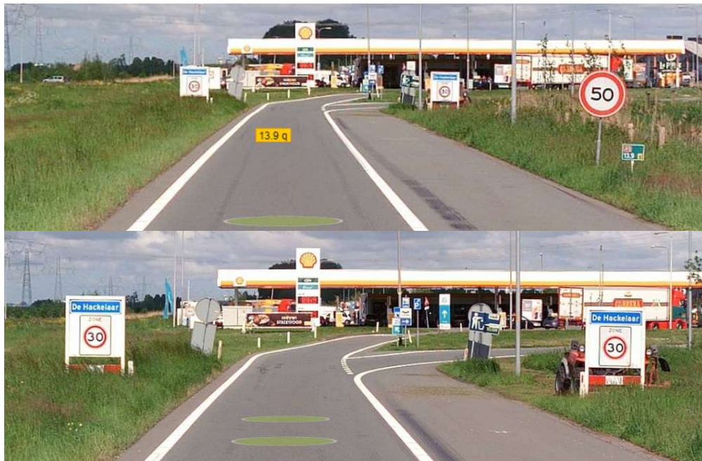
Boven: Situatie t.h.v. A1 hmp 13.9q Onder: Situatie t.h.v. A1 hmp 13.85q
