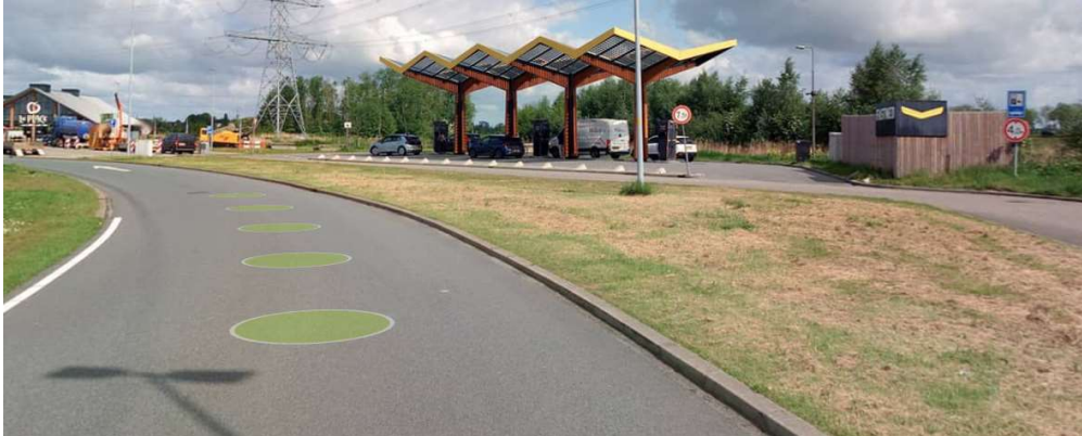
Situatie op de aanvoerweg, langs het laadstation.
