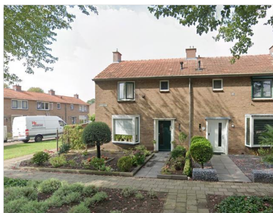
Figuur 2.3 Zuidoostelijk aanzicht woning Berkenlaan 12 (Google streetview).
