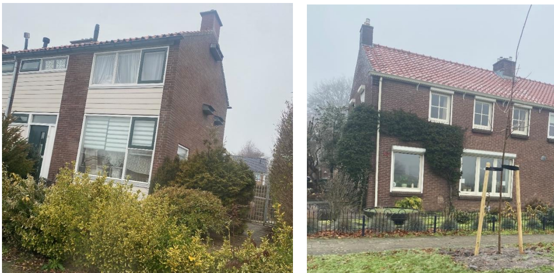
Figuur 1. Poelsweg 7 te Keijenborg, drie tijdelijke huismuskasten met zeven verblijfplaatsmogelijkheden aanwezig (L). Ruurloseweg 57 te Hengelo, begroeiing op de voor en zijgevel van het huis (R).
