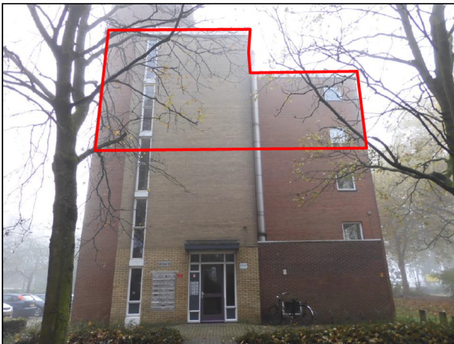
Figuur 4. De volledige gevel aan de noordzijde kan onderdeel zijn van de kraamverblijfplaats gewone dwergvleermuis.
