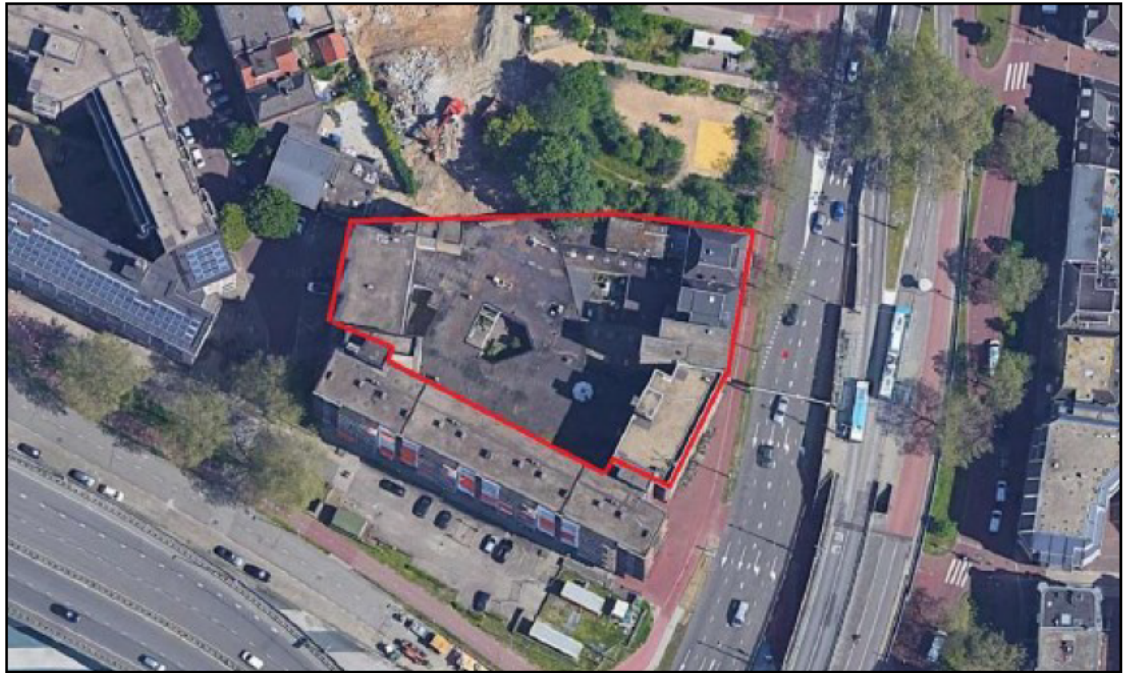
Afbeelding 2: Het projectgebied, betreffende het te slopen appartementencomplex aan Nieuwe Plein 1B in Arnhem.
