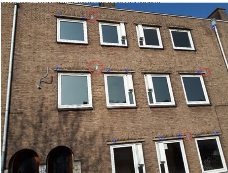
Detail exclusion flap (rood) en afdichten open stootvoegen
