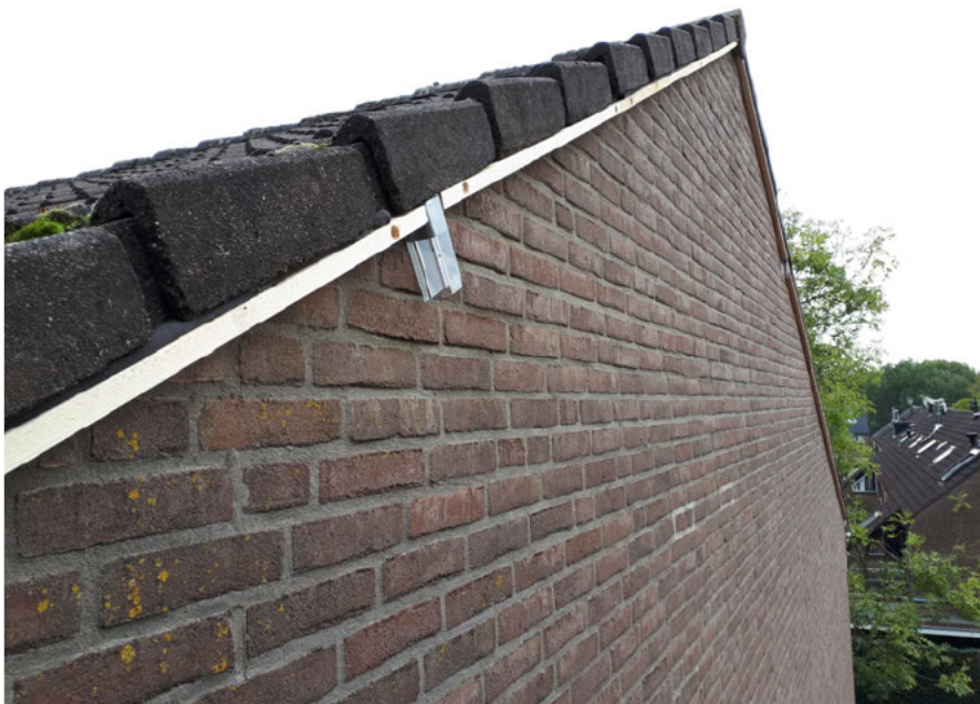
Detail exclusion flaps met panlatten en rugvulling.
