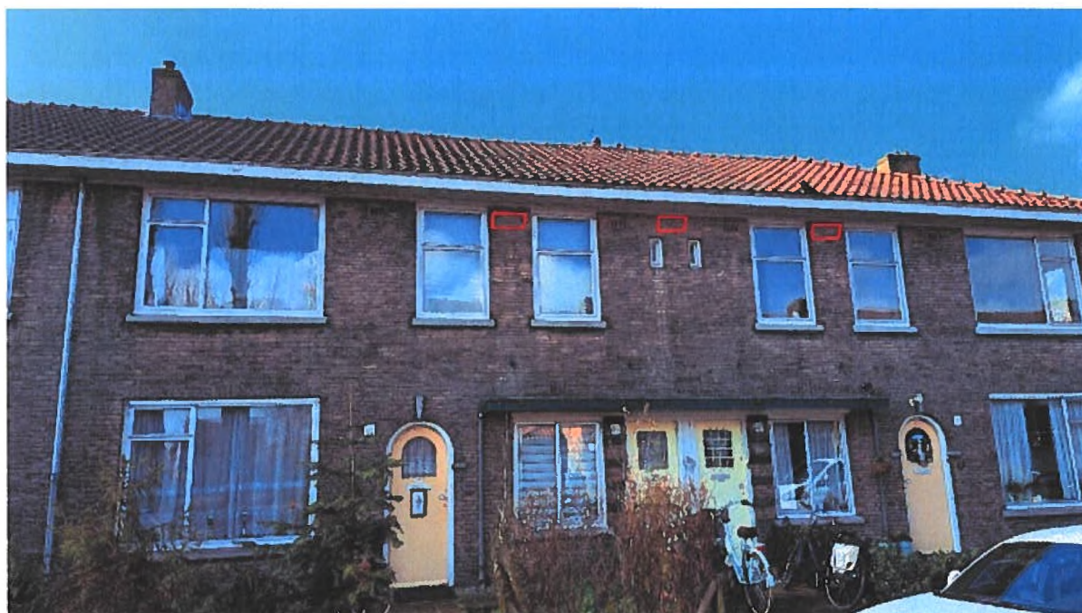
Locaties van de permanente alternatieve voorzieningen voor de gierwaluw aan de Heggerankweg 129, 131 en 133.
