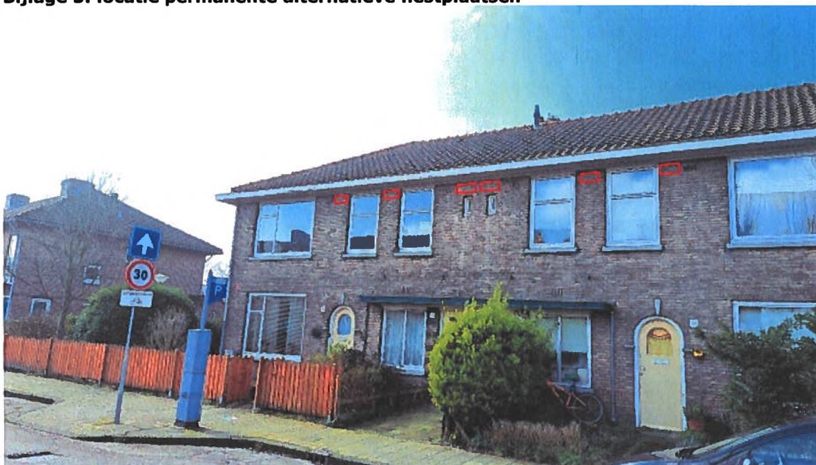
Locaties van de permanente alternatieve voorzieningen voor de gierwaluw aan de Heggerankweg 119, 121, 123 en 125.
