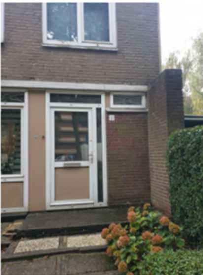
Betonvloer tpv entree
