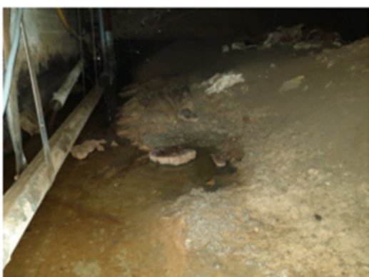
Veel grondwater ter plaatse van de fundering onder de woningscheidende bouwmuren.
