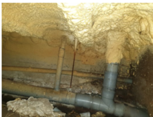
Ter plaatse van 1 woning is de onderzijde vloer geïsoleerd met PUR-schuim.
