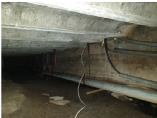
koperen afvoer fontein en metalen doorvoer wc op kunststof riolering.
