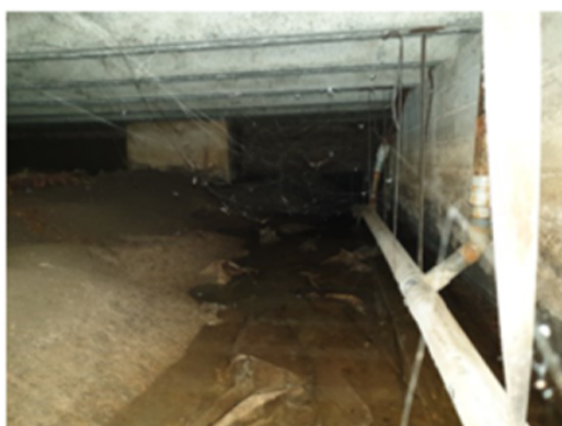
Veel grondwater ter plaatse van de fundering onder de woningscheidende bouwmuren.
