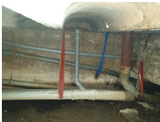
koperen afvoer fontein en metalen doorvoer wc op kunststof riolering.
