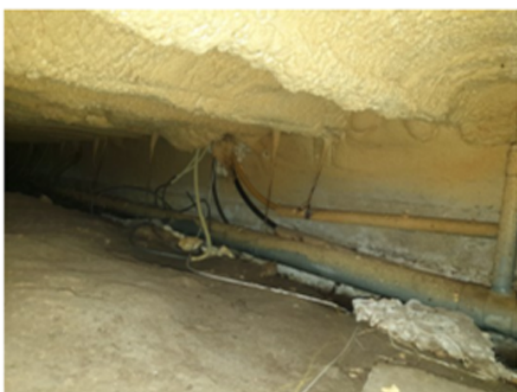
Ter plaatse van 1 woning is de onderzijde vloer geïsoleerd met PUR-schuim.
