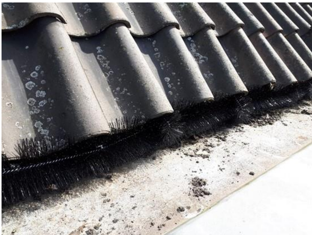
Details ongeschikt maken boeidelen met panlatten en exclusion flaps. Dezelfde methode kan ook onder overstekken gebruikt worden.
