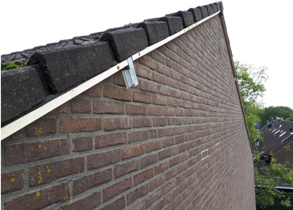
Detail exclusion flaps met panlatten en rugvulling.
