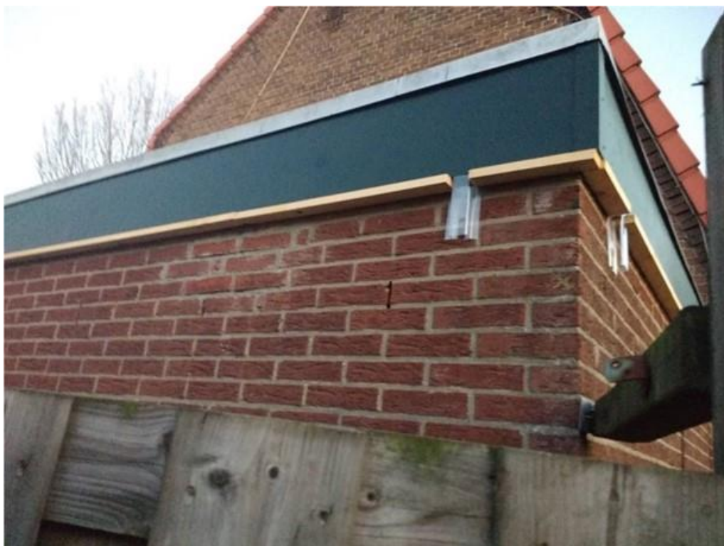
Details ongeschikt maken boeidelen met panlatten en exclusion flaps. Dezelfde methode kan ook onder overstekken gebruikt worden.
