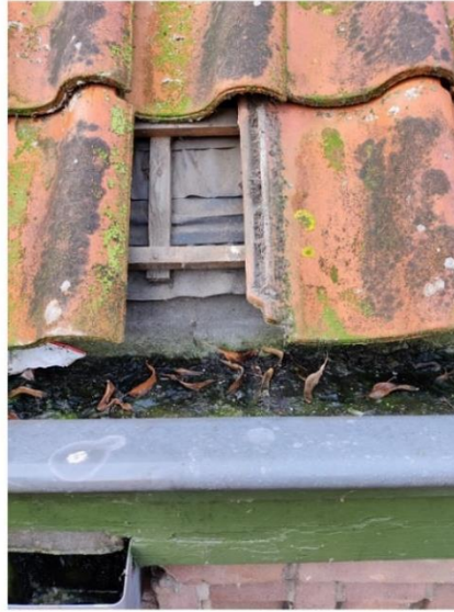
Voor ongeschikt maken, situatie onder
