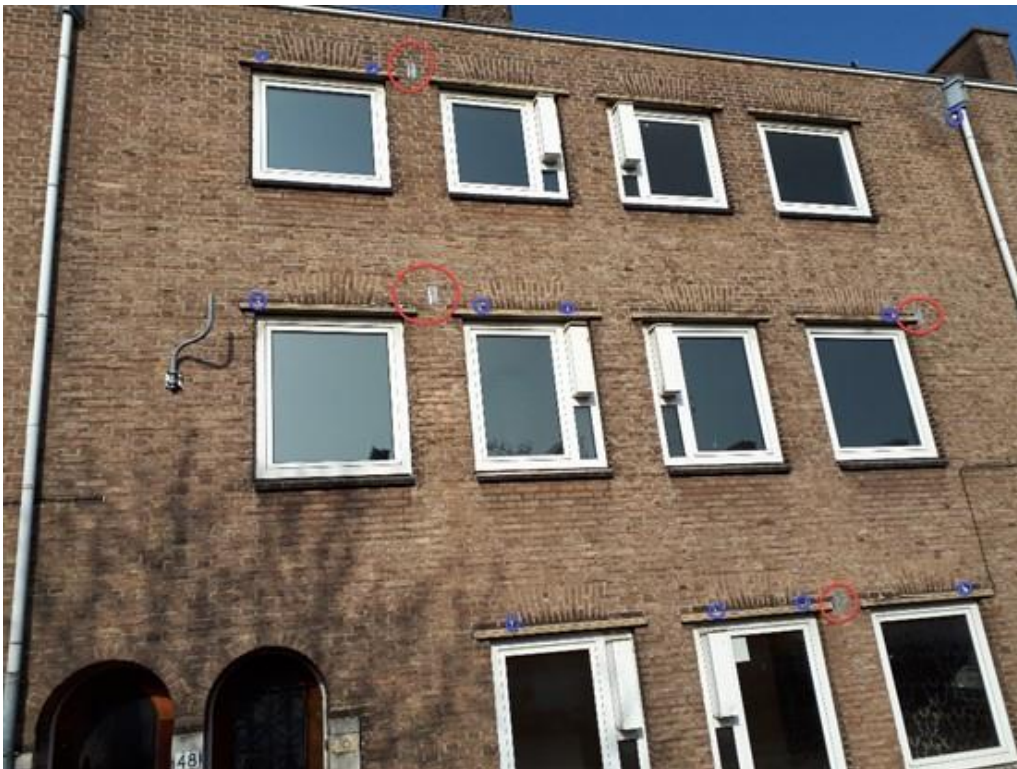
Detail exclusion flap (rood) en afdichten open stootvoegen. Tijdens het ongeschikt maken worden alle stootvoegen beoordeeld. Doorlopende open stootvoegen worden afgedicht met exclusion flaps en rugvulling, bijenbekjes of spouwmuurborstels. De ondiepe, niet doorlopende stootvoegen, worden afgedicht met pur (blauw).
