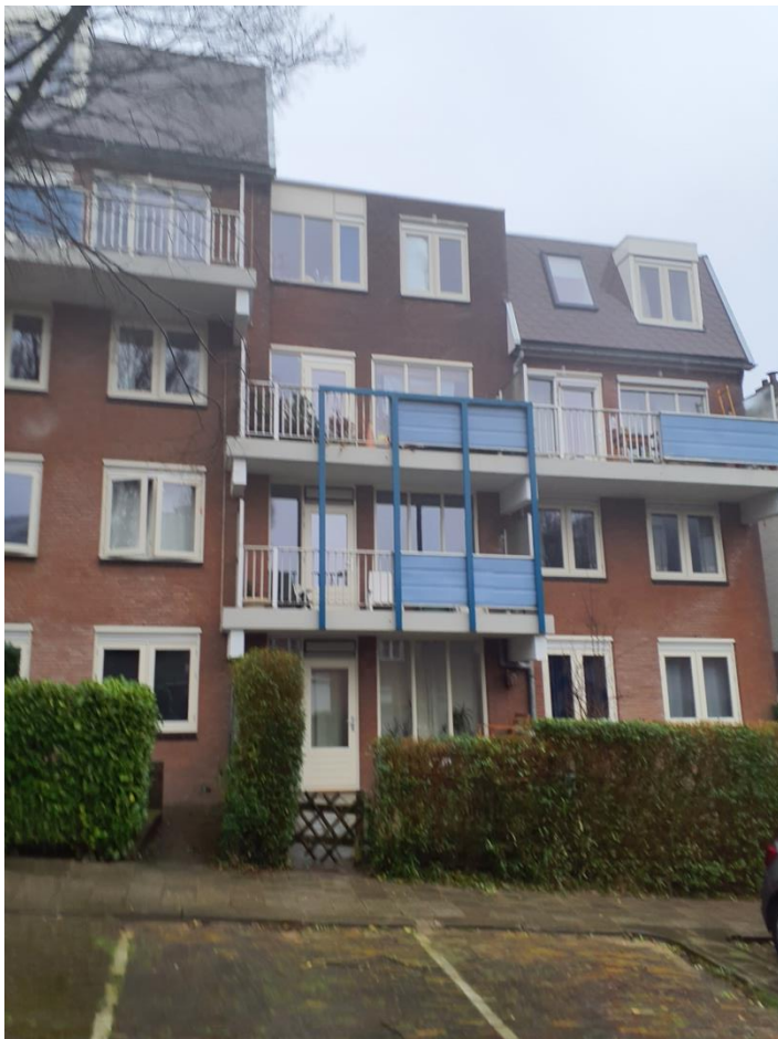
Foto 6: Gevelaanzicht achterzijde pand.
