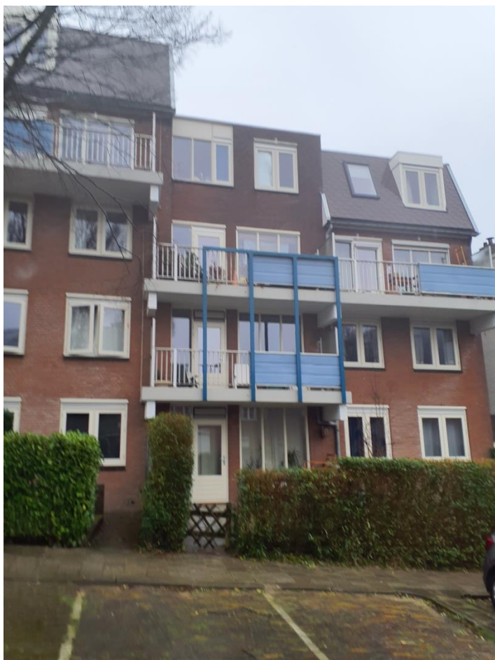
Foto 6: Gevelaanzicht achterzijde pand.
