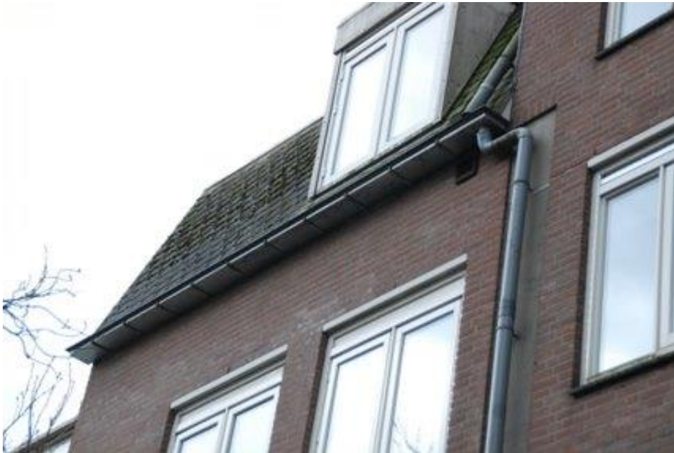
Foto 1: Gevelstructuur projectgebouw. Opening achter dakgoot, stootvoeg en ruimte rond regenpijp zichtbaar.
