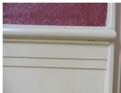
Deklijst van de lambrisering
