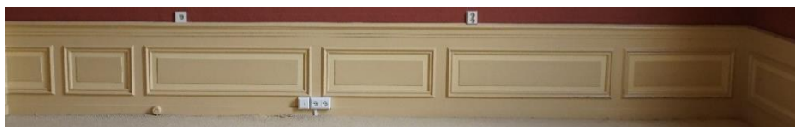
Lambrisering langs de westmuur
