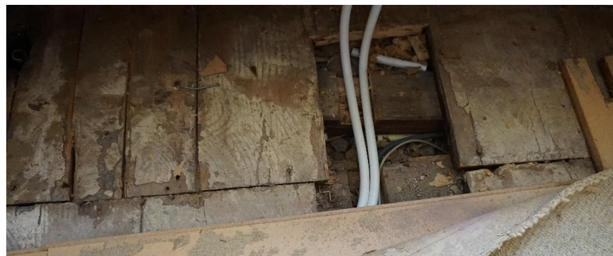
Houten balklaag onder de vloerbedekking bij de vensters aan de noordzijde
