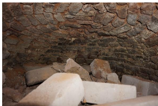
Koepelgewelf achter de opening in de zuidmuur
