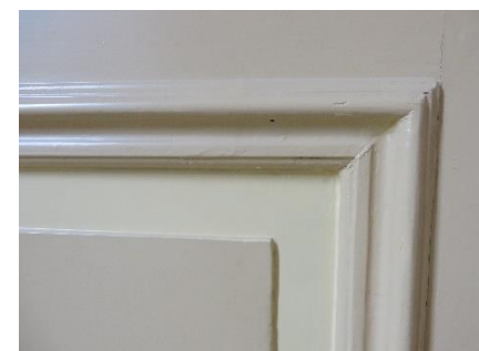
Detail van een paneel van de lambrisering
