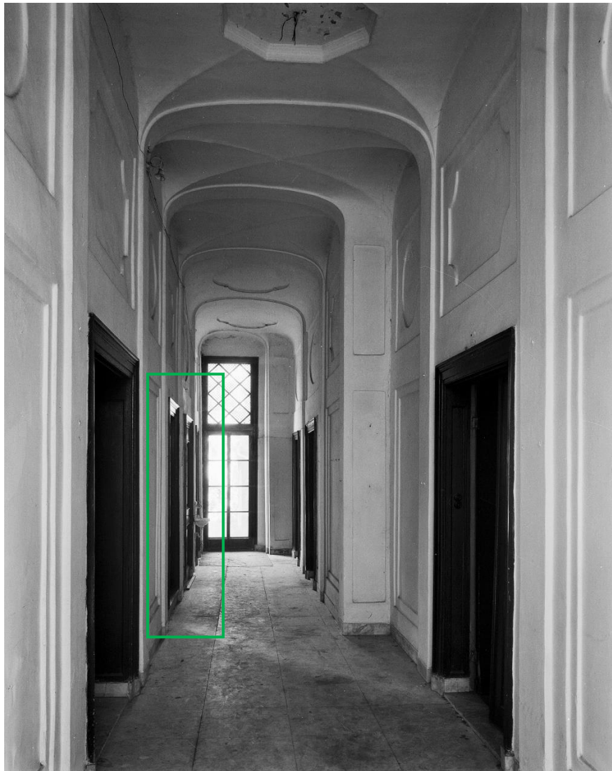
Gang in bouwdeel B in mei 1959 - voor de restauratie van 1959-1962. Links in het midden de deur naar de noordkamer in A2; daarachter de deur naar de kelder. (RCE 057680)
