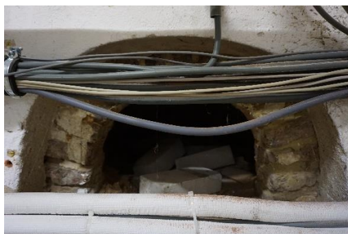
Opening in de zuidmuur
