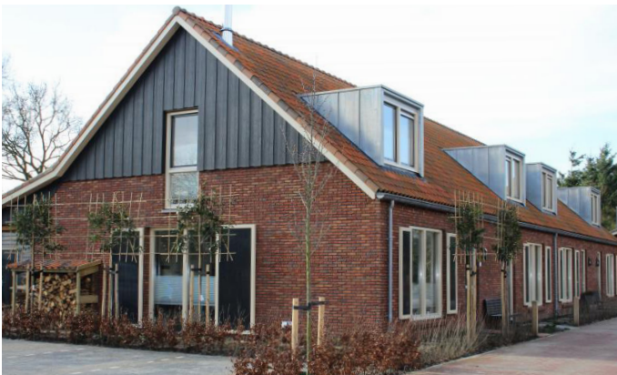
▷ Gepotdekselde gevels en rood-bruin metselwerk
