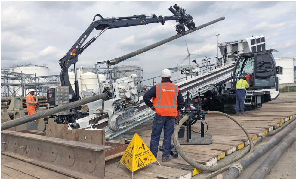
Figuur 9 Boorstelling 300 tons boorstelling (schets)
