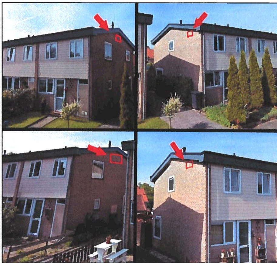
Figuur 16. VLNR: [REDACTED] en 11 (boven), [REDACTED] en 19 (Onder) met locaties waar de inmetselfkasten gerealiseerd dienen te worden; niet in de verstorende zone van ramen, lampen of begroeiing.
