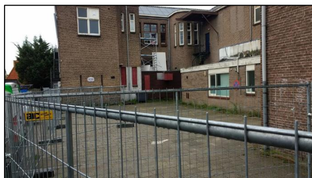
Foto 6: Onderzoekslocatie gezien in zuidoostelijke richting
