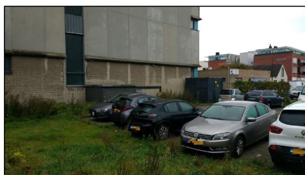
Foto 12: Noordzijde van de onderzoekslocatie, grasstrook naast de parkeerplaats
