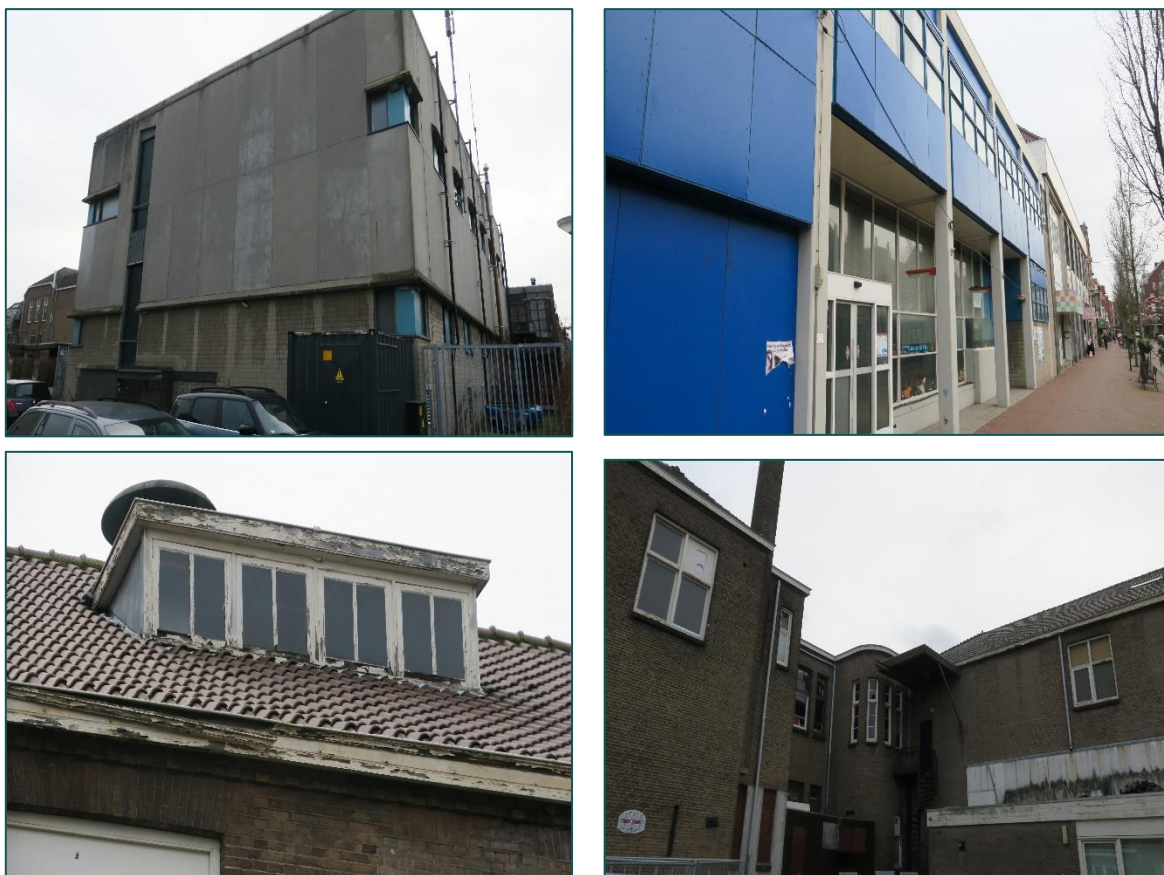
Figuur 1.3 Visualisatie van de planlocatie: bovenste foto's bebouwing met plat bitumen dak, onderste foto's bebouwing met pannendak (mansardedak).
