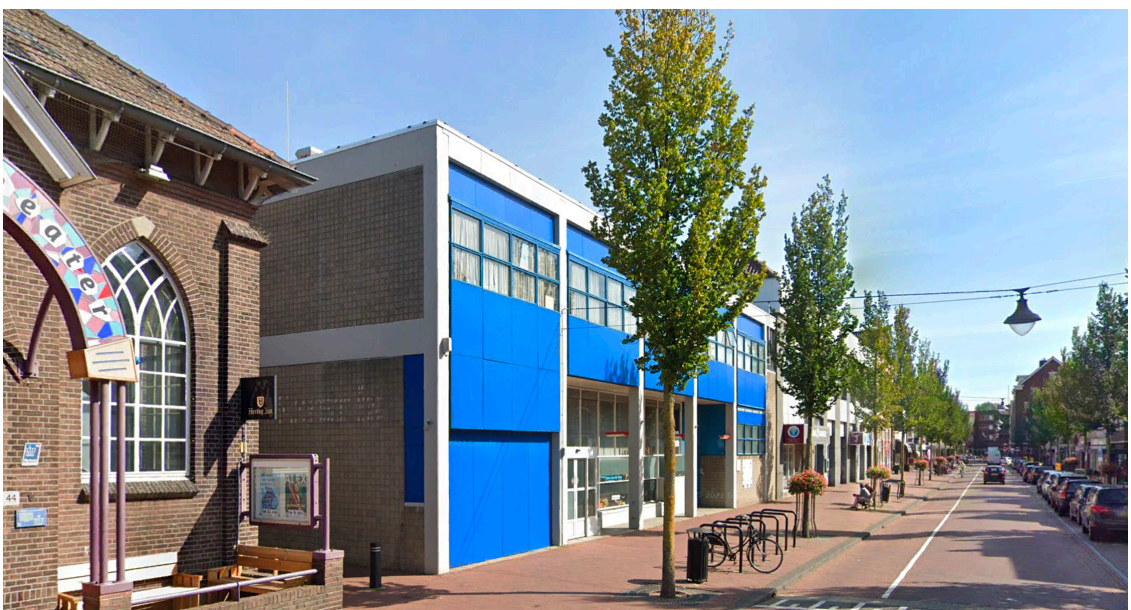
Fig. 3.2 Bestaande situatie Damlaan (met ingang Damsteegje)
